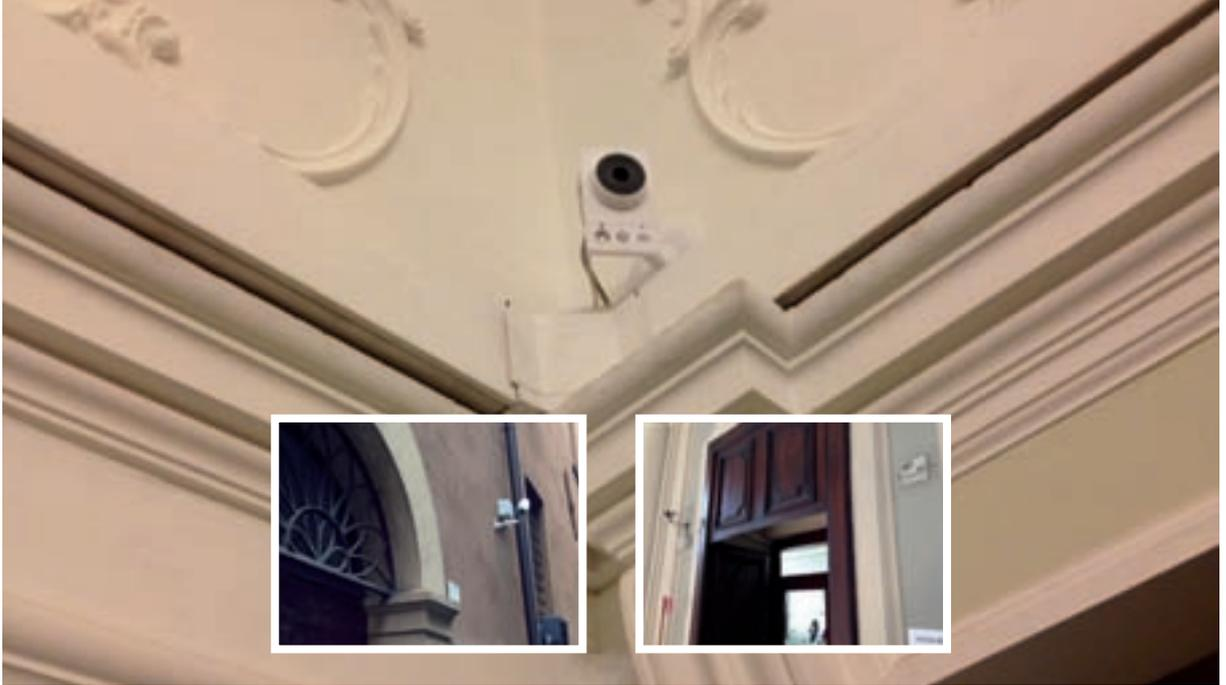
risparmio energetico nei momenti di non utilizzo. Il controllo completo delle zone pubbliche e l'archiviazione del flusso video hanno richiesto l'installazione di tre videoregistratori di rete (NVR) D-Link DNR-322L, in grado di registrare simultaneamente da un numero massimo di nove videocamere ciascuno, 24 ore su 24, in determinati intervalli di tempo (ad esempio, di notte o durante i fine settimana), o sulla base di eventi, come il rilevamento di movimenti.
