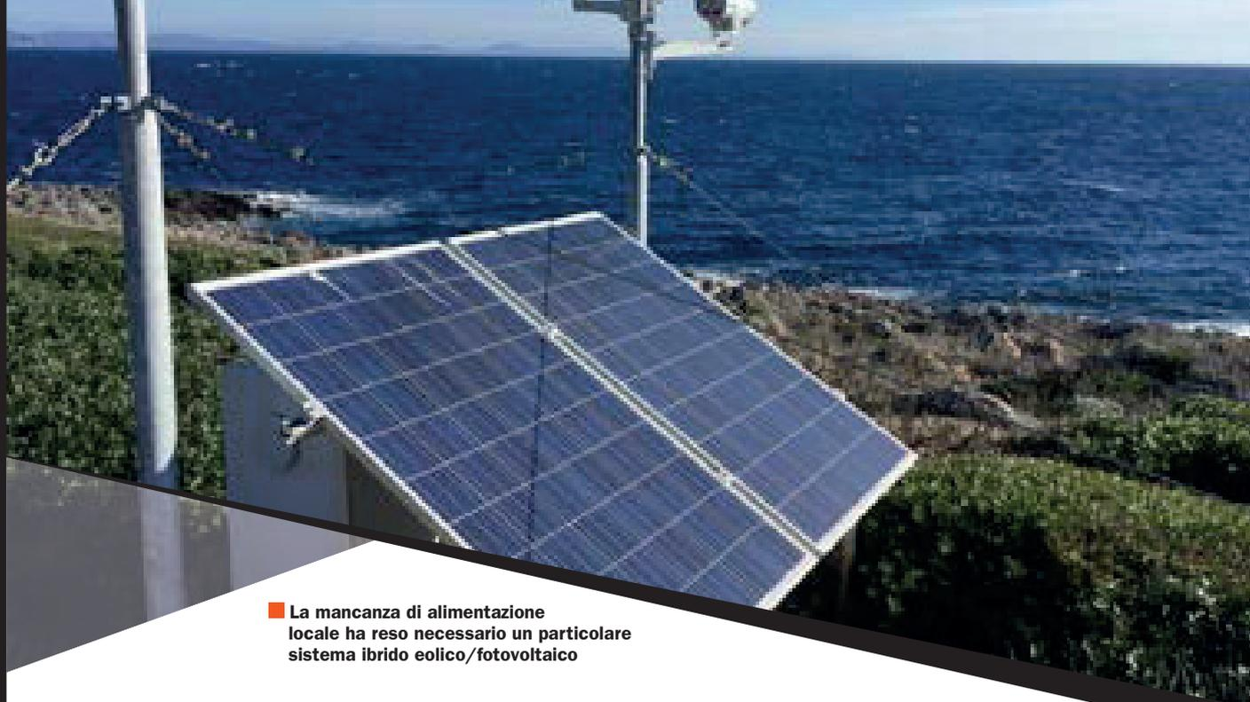
■ La mancanza di alimentazione locale ha reso necessario un particolare sistema ibrido eolico/fotovoltaico
