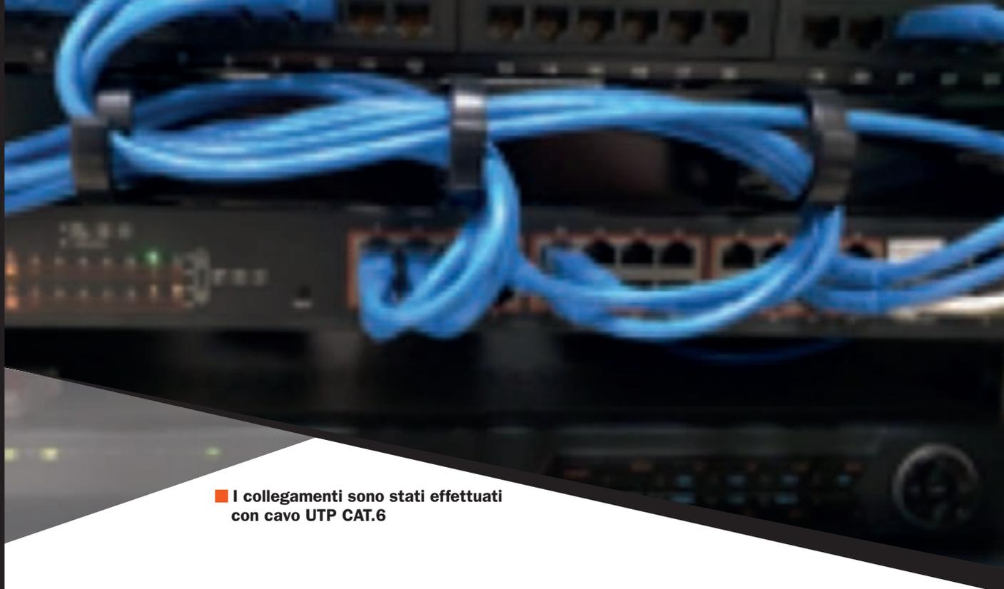
■ I collegamenti sono stati effettuati con cavo UTP CAT.6
